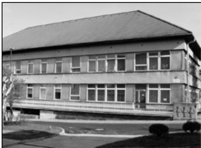
Původní budova MŠ
