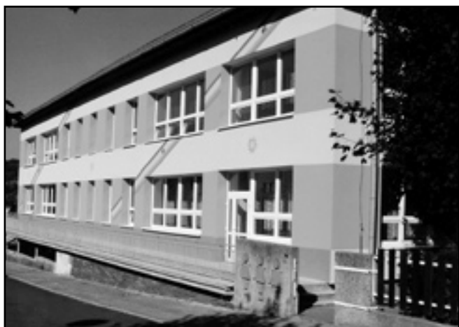
Po rekonstrukci - září 2010
